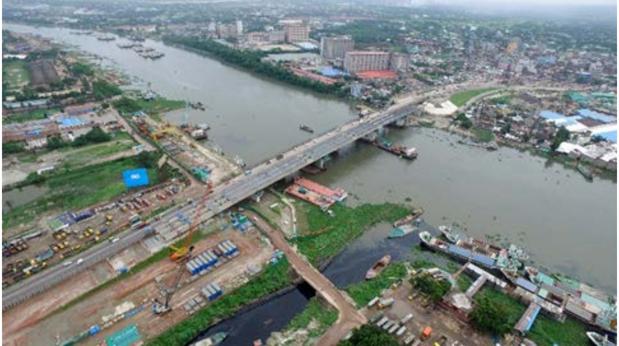
カチプール橋建設状況(2018年6月)
