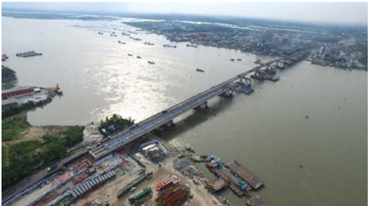
メグナ橋建設状況(2018年6月)
